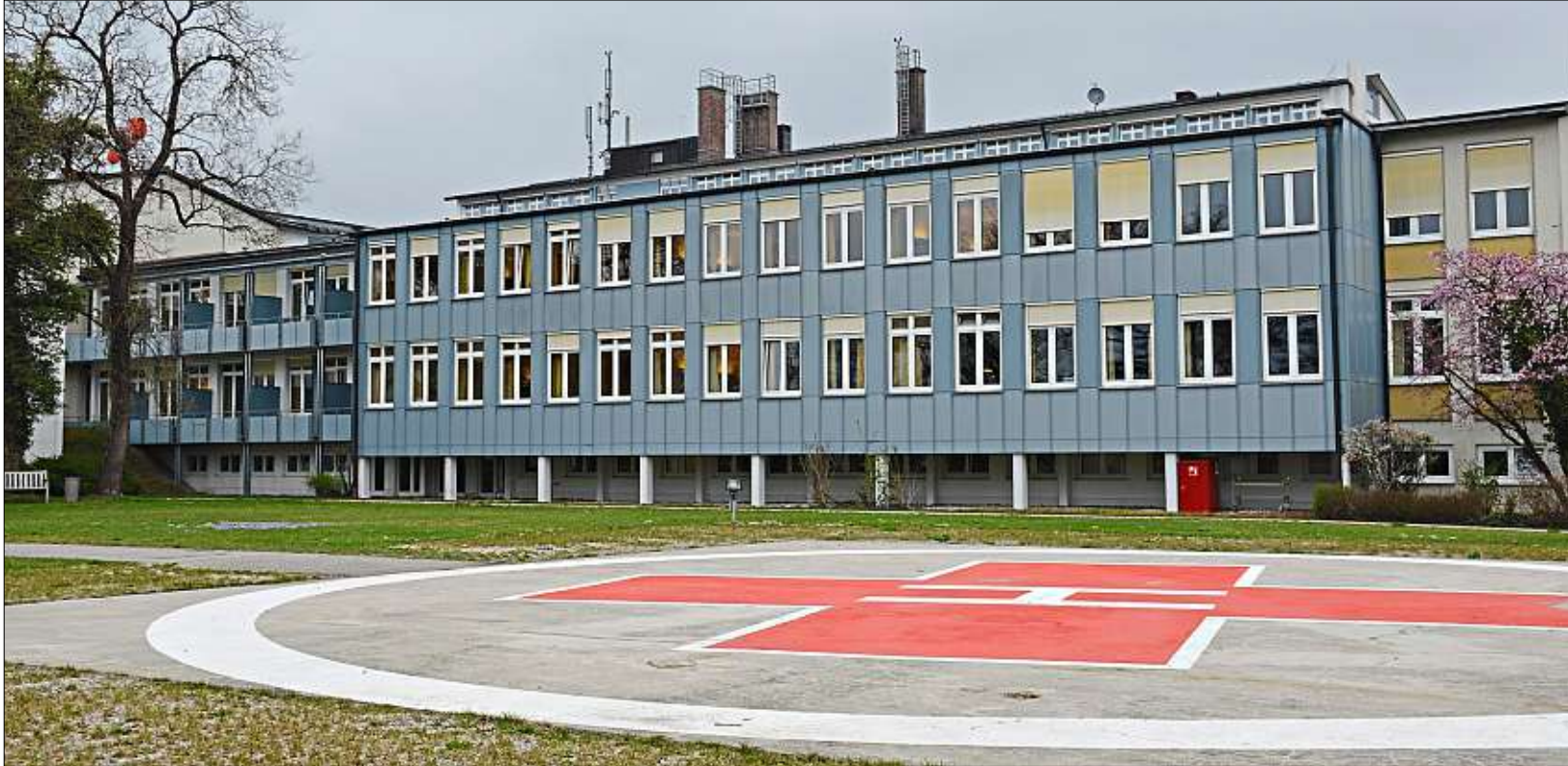
Die Kreisklinik Burghausen ist baulich in hervorragendem Zustand. Gerade während des Umbaus in Altötting ist das Haus als Ersatzquartier und bei Engpässen wichtig. Das Klinik hat zudem einen großzügigen Garten, den Patienten aufsuchen können. – Fotos: Wetzl
