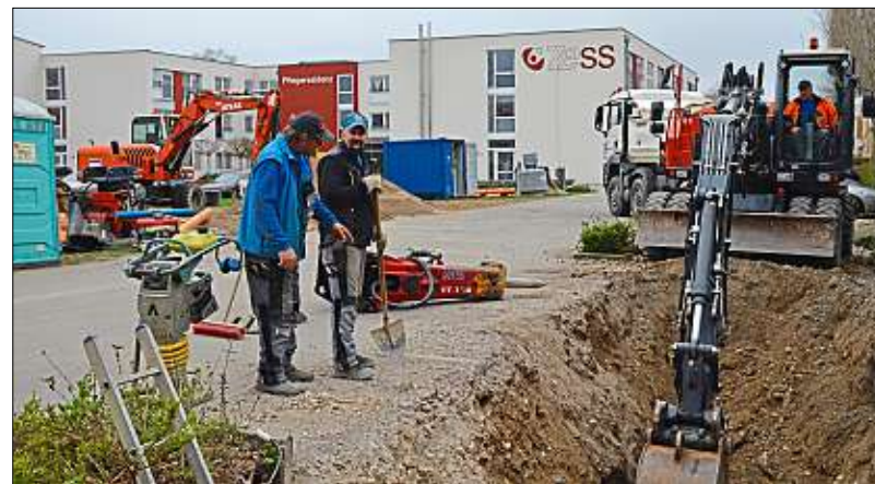
Vor dem Pflegezentrum ZesS bauen Klaus Schultheiß und Karl Aigner 55 Wohnungen, einen Teil barrierefrei. Die Arbeiten haben jetzt begonnen.
